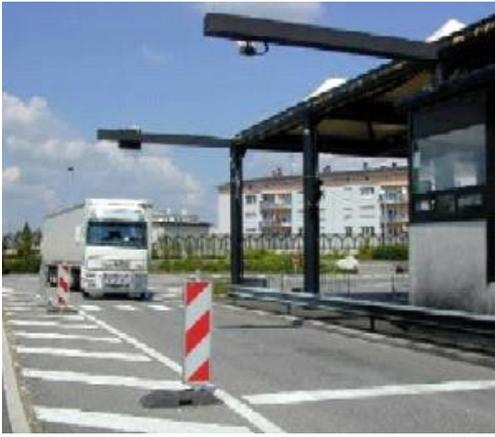
Beim Grenzübertritt wird die Kilometraufzeichnung automatisch ein- oder ausgeschaltet. Dies geschieht über eine kurzreichweitige Mikrowellen-Funkverbindung. An den Grenzübergängen sind dafür Funkbaken über den Fahrbahnen installiert. Diese Funktechnologie ist unter dem Kürzel DSRC (Dedicated Short-Range Communication) bekannt und für die elektronische Gebührenerfassung europaweit standardisiert.
