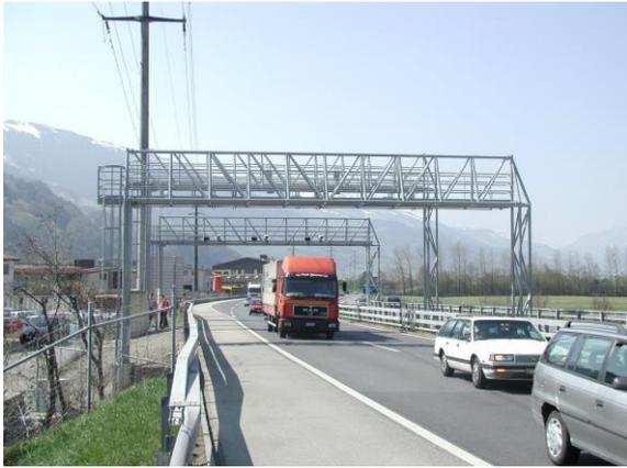
Bei zur Zeit 27 fixen Kontrollanlagen auf dem schweizerischen Autobahnnetz werden die Daten des Erfassungsgerätes über die DSRC-Funkverbindung ausgelesen und mit den von der Anlage elektronisch gemessenen Daten (Kontrollschild, Fahrzeuglänge, etc.) automatisch verglichen. Ausländische resp. Fahrzeuge ohne Erfassungsgerät werden über das Kontrollschild erkannt. Ein auf dem restlichen Strassennetz eingesetztes Fahrzeug kann standortunabhängig eingesetzt werden.
